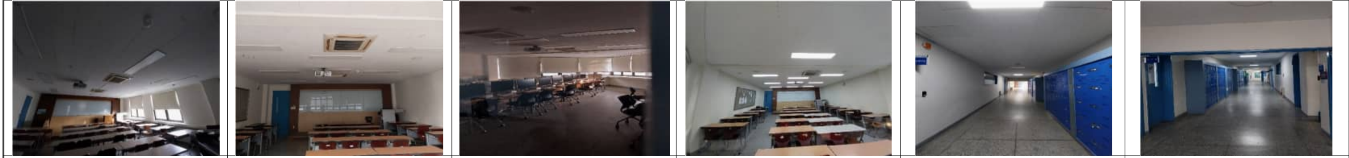
425호 유아교육실습실 천장사진 424호 강의실 천장사진 423호 강의실 천장사진 422호 강의실 천장사진 복도 천장사진 -1 복도 천장사진 -2
